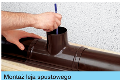
Montaż leja spustowego
