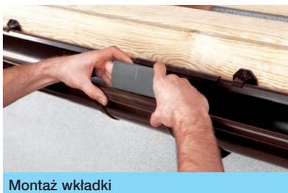
Montaż wkładki
