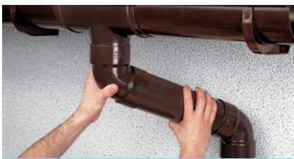
Montaż rury spustowej za pomocą dwóch kolan i odcinka rury
