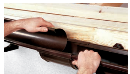
Montaż złączki rynny
