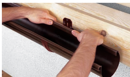
Montaż rynny w uchwytych stalowych
